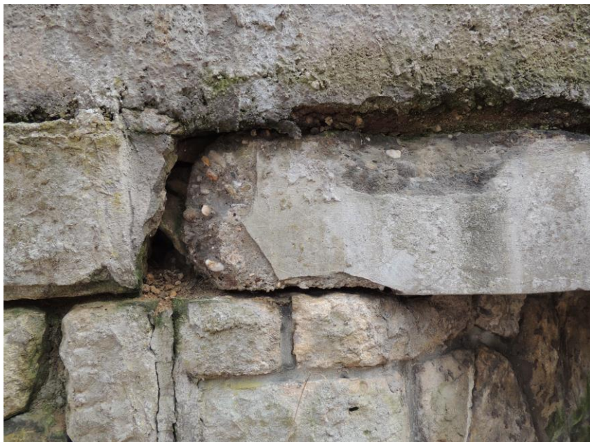
Degradovaný beton nosné konstrukce v uložení na pravou opěru a popraskané a vydrolené stykové spáry pravé opěry – vtoková část
