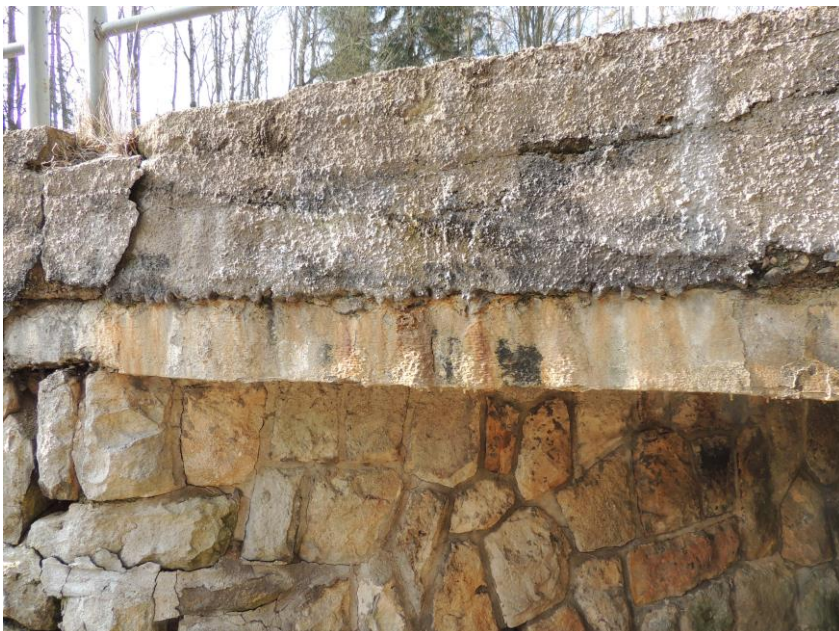
Degradace betonu nosné konstrukce
