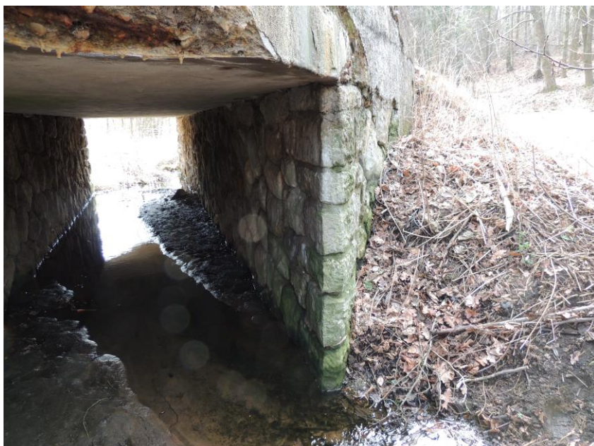
Pohled na levou opěru na vtoku, degradovaná hrana betonu nosné konstrukce vlivem korodující výztuže
