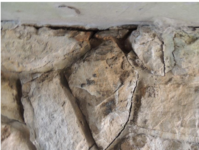
Popraskaná styková malta na levé opěře, vložena asfaltová izolace na styku nosné konstrukce s opěrou
