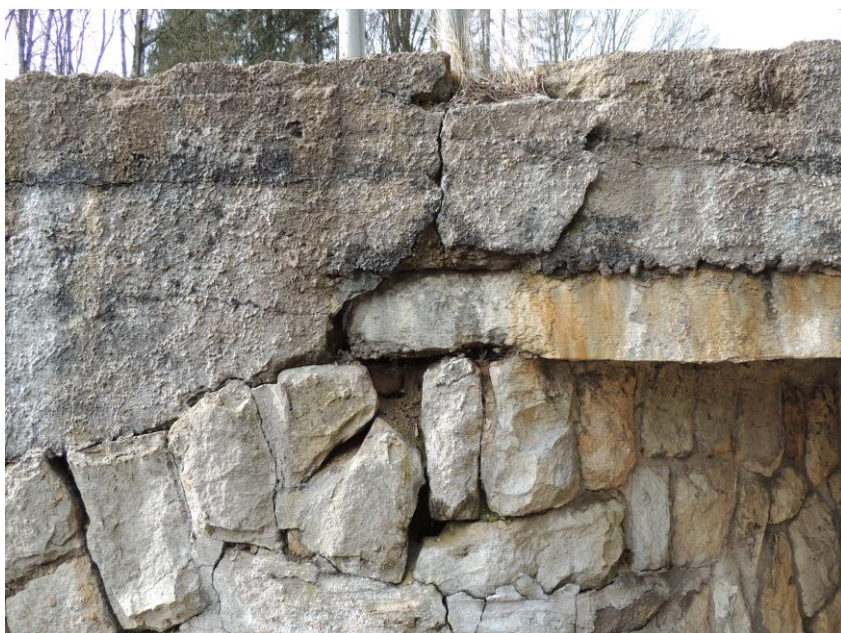
Uložení nosné konstrukce na levou opěru, popraskané a vydrolené stykové spáry – výtoková část
