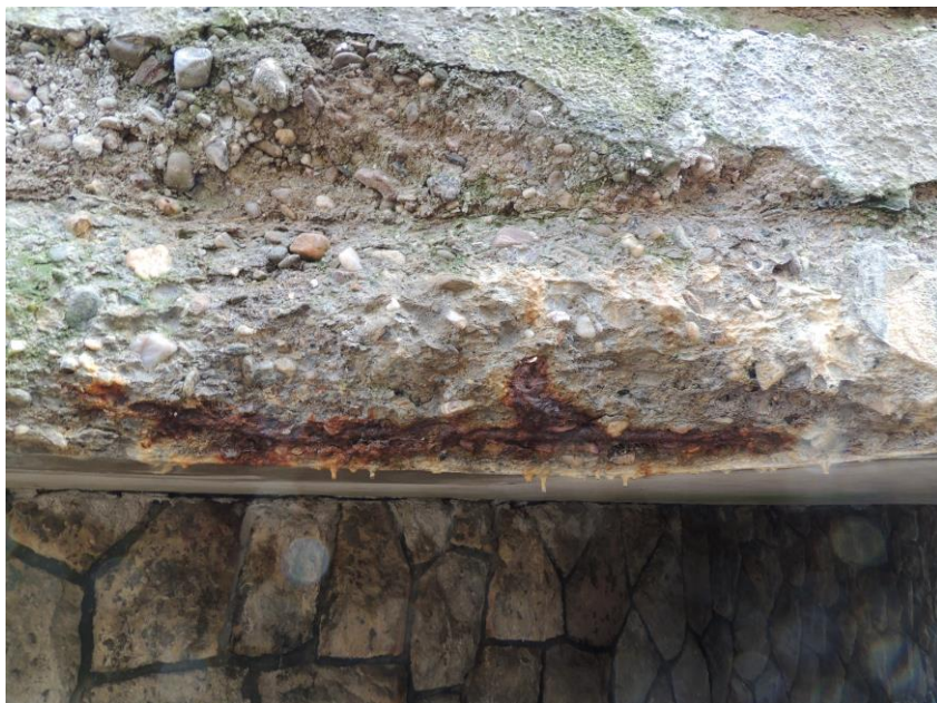
Degradovaný beton nosné konstrukce na vtokové straně mostu a korodující výztuž
