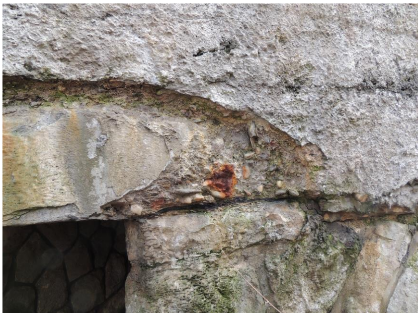
Degradovaný beton v uložení nosné konstrukce na levou opěru – vtoková část
