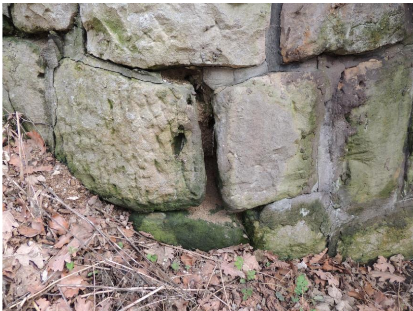
Popraskaná a vydrolená styková malta na pravé opěře – vtoková část
